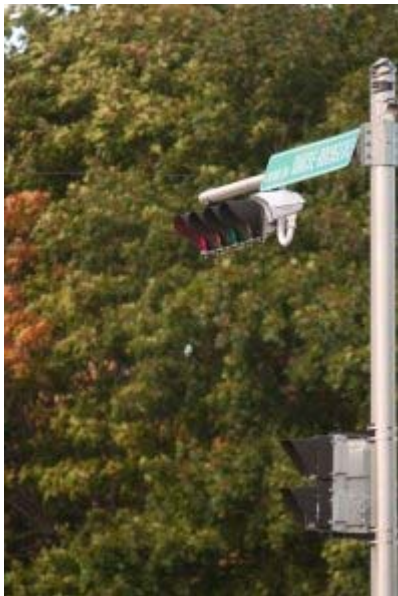
Namestitev detektorja na obstoječi semaforski drog
